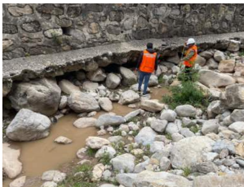
IMAGEN 01: SE MUESTRA EL ESTADO ACTUAL DE LAS MARGENES DE LA QUEBRADA MASHUARAGRAHUAYJO REQUIERE DE DEMOLICION DE MURO EXISTENTE
