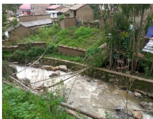
IMAGEN 04: SE MUESTRA EL ESTADO ACTUAL DEL CAUCE DE LA QUEBRADA MASHUARAGRAHUAYJO SE REQUIERE DE DEMOLICION DE MURO DE CONCRETO Y EL MEJORAMIENTO MEDIANTE MUROS DE PROTECCION ANTE INUNDACIONES
