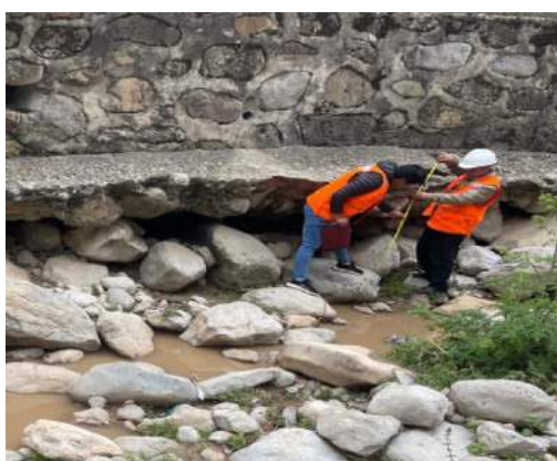
IMAGEN 03: SE MUESTRA EL ESTADO ACTUAL DE LA MARGEN IZQUIERDA DE LA QUEBRADA MASHUARAGRAHUAYJO REQUIERE DE LIMPIEZA Y DESCOLMATACION Y CONSTRUCCION DE MURO DE CONCRETO
